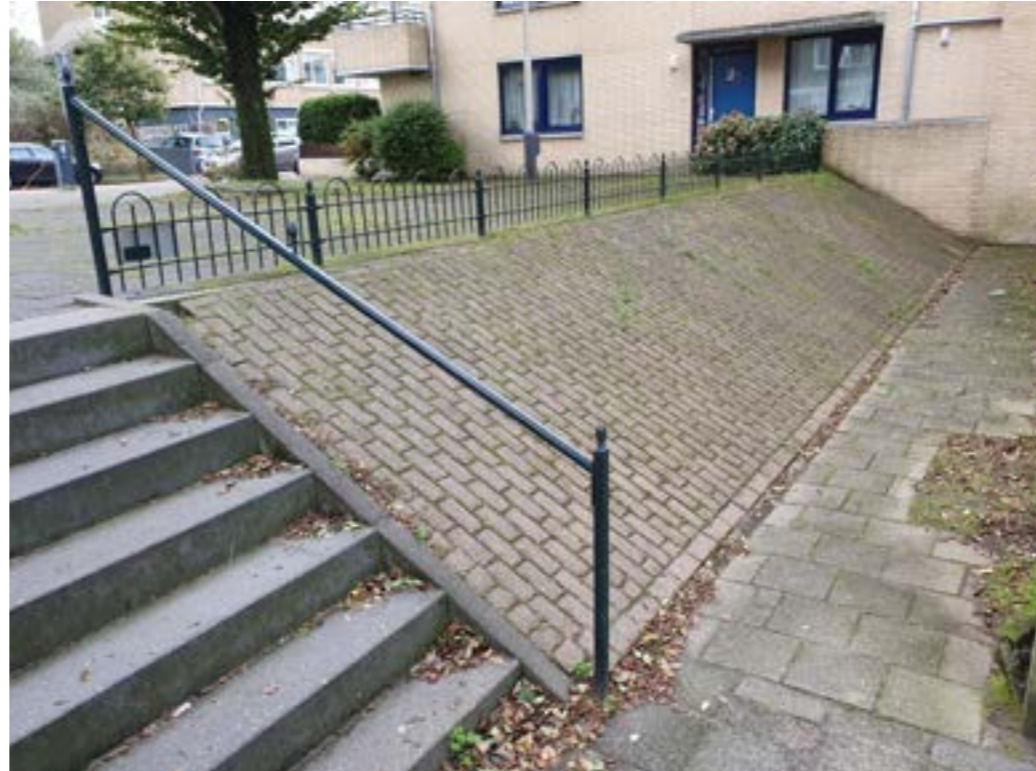
aanwezig talud tussen woningen en plein
