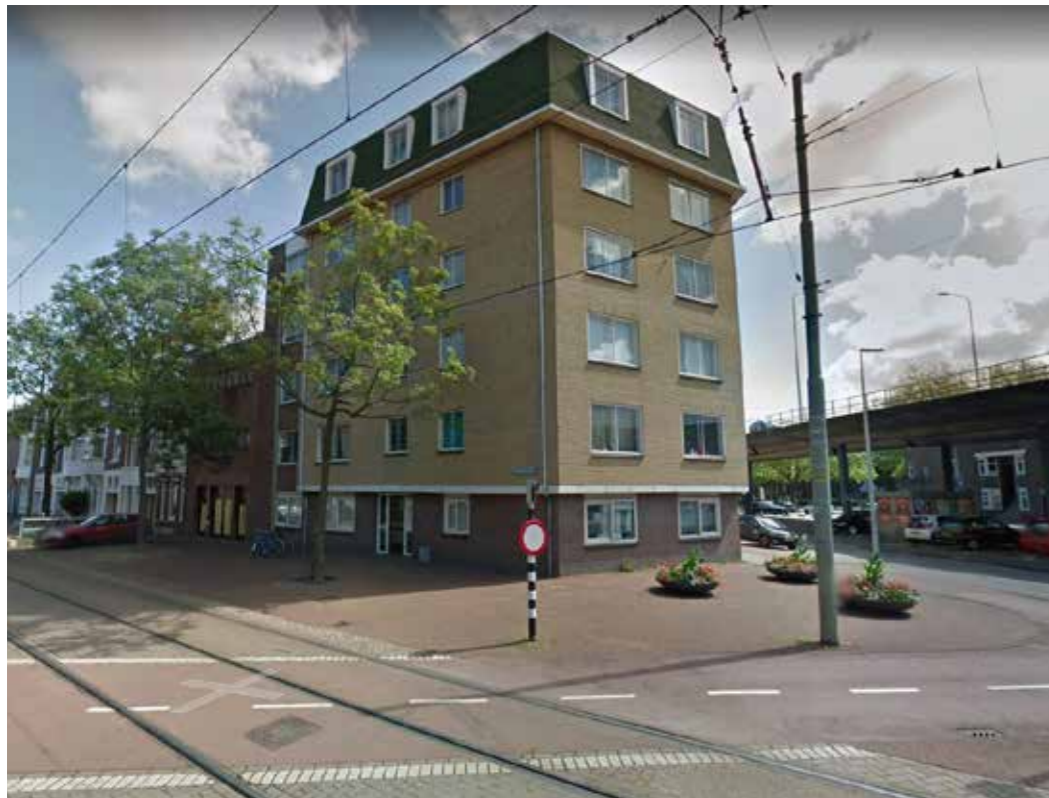
zicht op versteende voorruimte woningen Weteringplein zuidzijde
