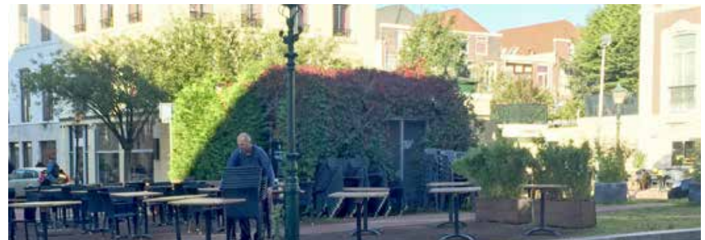
verticaal groen: zorgvuldigheid bij de keuze van soorten is van belang om beschadigingen in het trafo-huis te voorkomen (toepassen slingerplanten in plaats van hechtende klimmers)
