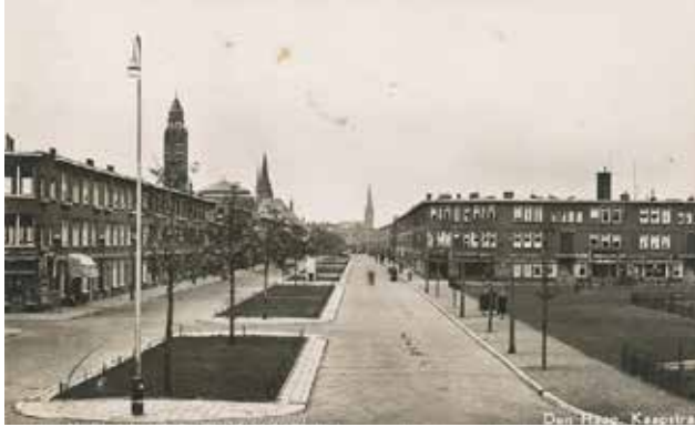
Kaapstraat en Kaapseplein bij aanleg van de wijk Transvaal
